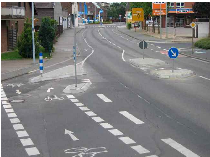
Bild 4: Bauliche Ausbildung des Endes eines linken Radweges in Bergheim (Foto: Ulrich Kalle, ADFC NRW)
